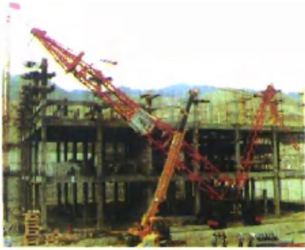
新疆煤矿建设工程处承建的 艾维尔沟煤矿洗煤工程主井井筒
