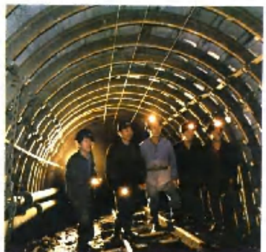
哈密矿务局一矿加固后的主斜井井筒
