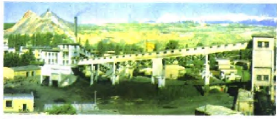
乌鲁木齐矿务局苇湖梁煤矿
