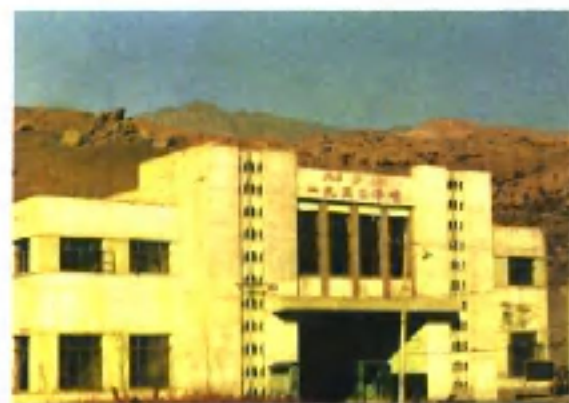
艾维尔沟煤矿一九三〇平硐
