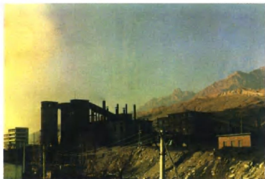
艾维尔沟煤矿洗煤厂
