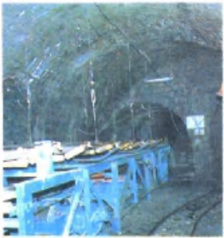
新疆煤矿建设工程处承建的 艾维尔沟煤矿洗煤工程主井井筒 安装提升机轨道
