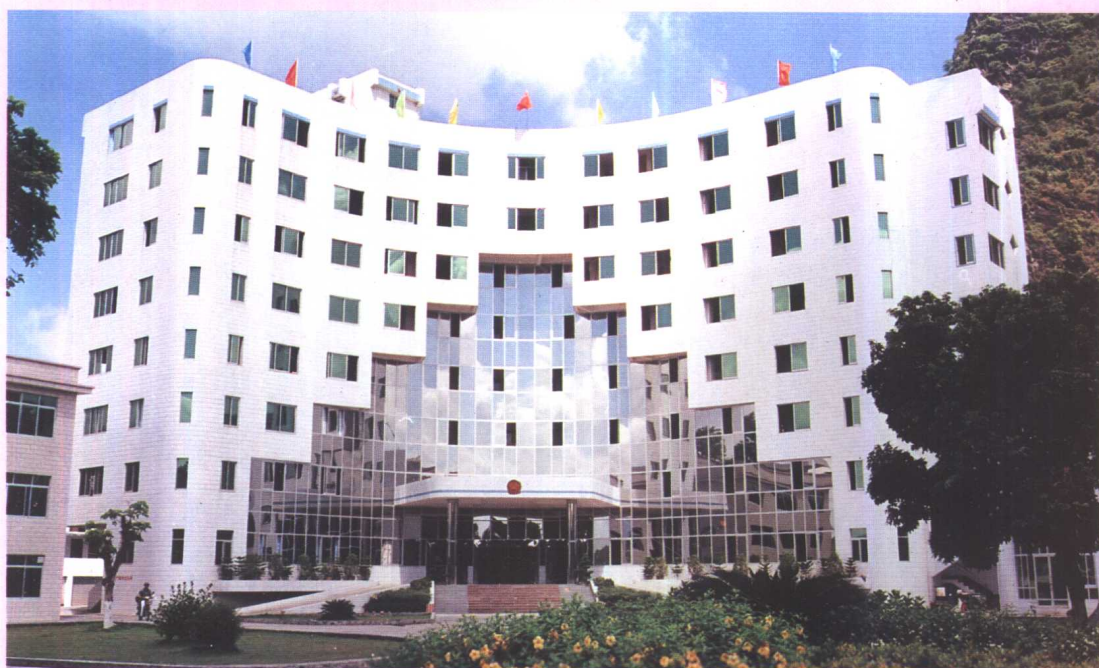
县政府办公大楼
