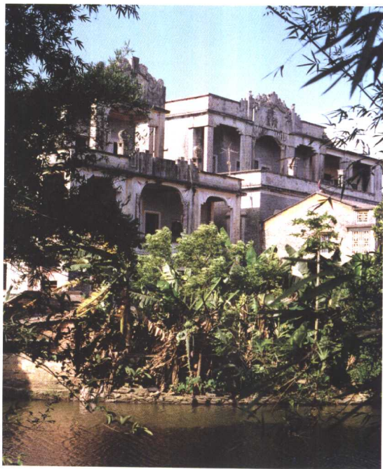
潭江之滨具有西洋建筑风格的开平碉楼（郑 静摄）
