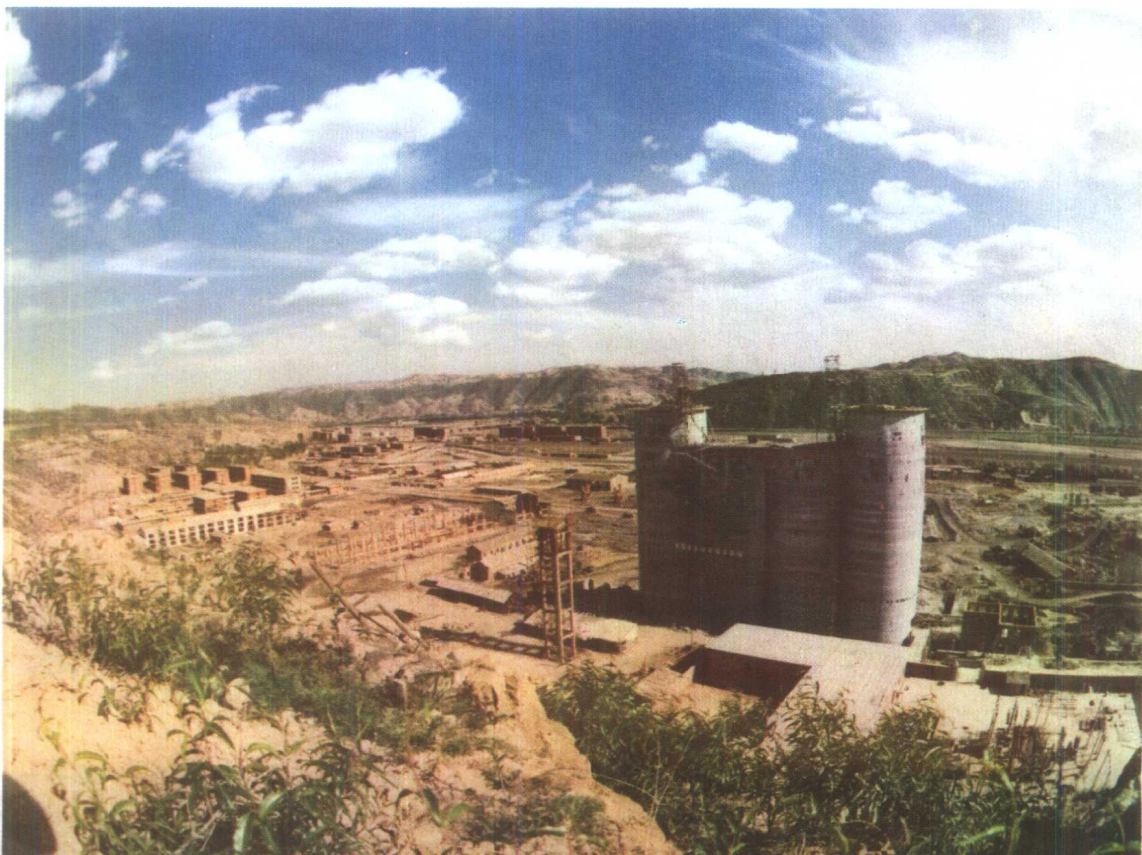
建设中的山西古交西曲煤矿 苏进 摄
