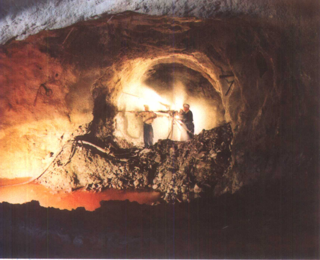
淮北煤炭建设指挥部第30工程处 “猛虎掘进队”在临涣矿井施工
