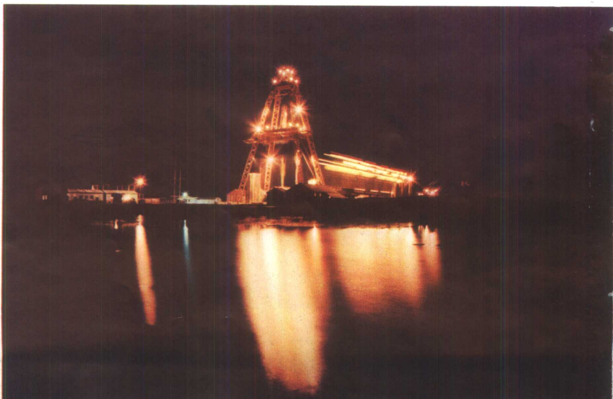
淮南矿区潘集3号矿井西风井采用钻井机凿井
