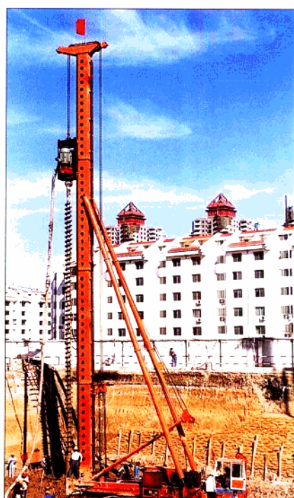
新河益农食品公司 CFG20 桩机在北京工地施工
