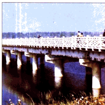
滏东排河邢家庄公路桥
