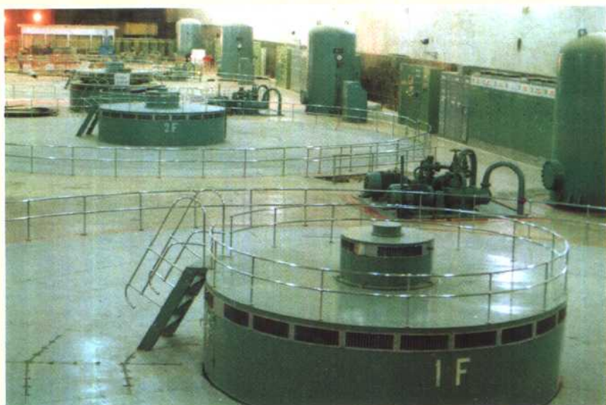
▲1984年，东方电机厂生产的当时国内最大的混流式33万千瓦水轮发电机组在龙羊峡电站运行
