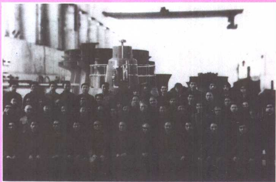
▲1981年,李先念等中央领导在工地接见参加二江电厂建设的有关单位代表和东方电机厂驻工地代表在17万千瓦机组前留影。
