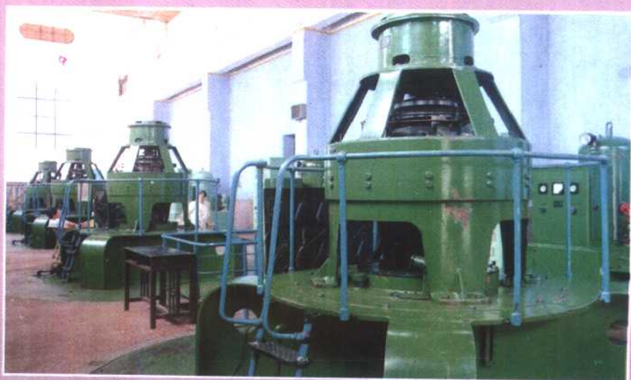
▲1959年，重庆水轮机厂设计制造长 寿大洪河水电站1台单机容量8150千瓦 混流式水轮发电机组
