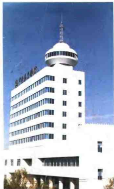
中国农业银行大洼县支行 办公楼
