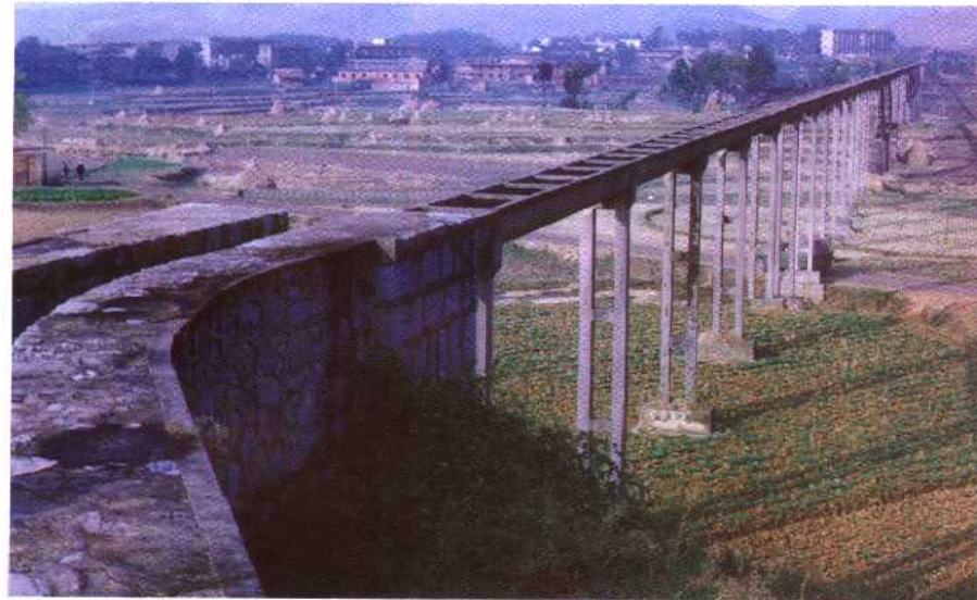
▲ 三岔乡烂碑堰薄壳渡槽
