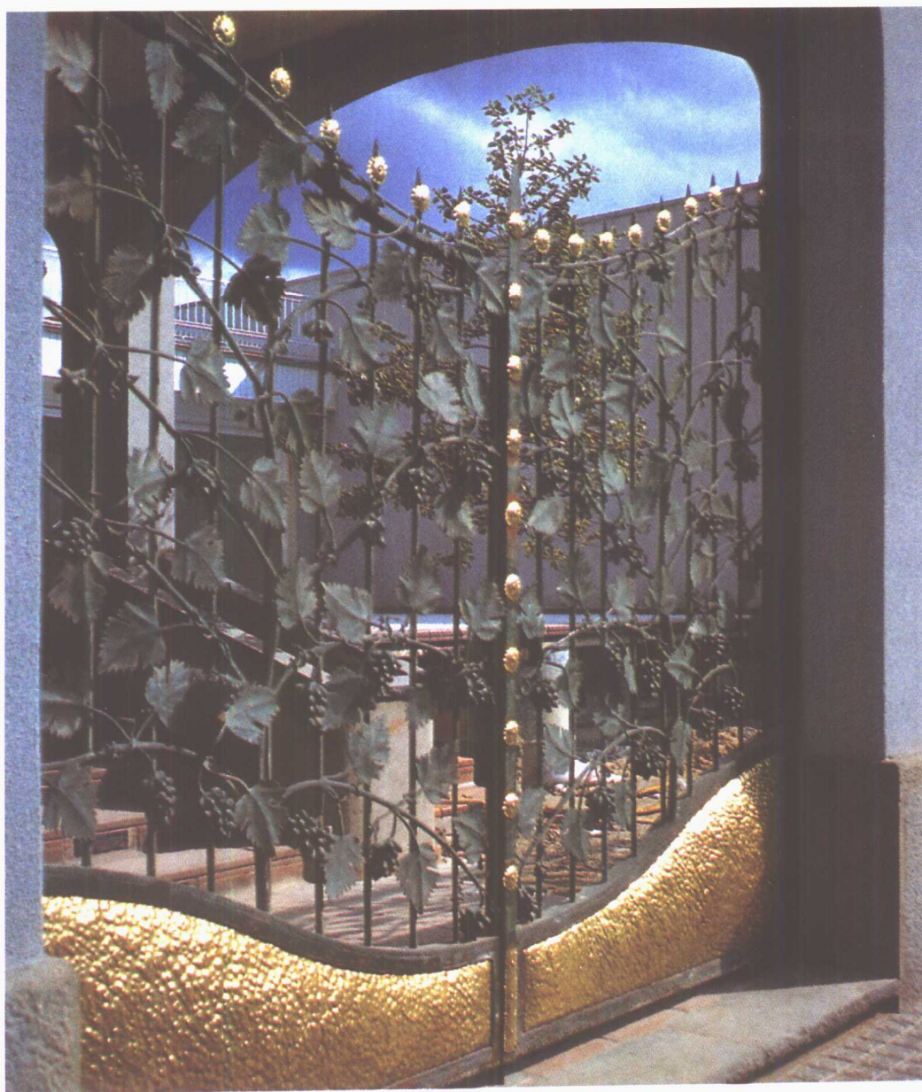
该门是采用方铁管制成的，中间和边上 是角铁制做，边缘条是锤 锻铜制成。
