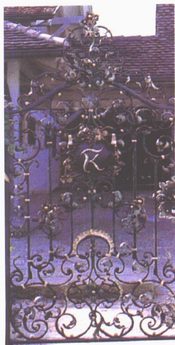
该门是采用方铁管制成的，中间和边上 是角铁制做，边缘条是锤 锻铜制成。
