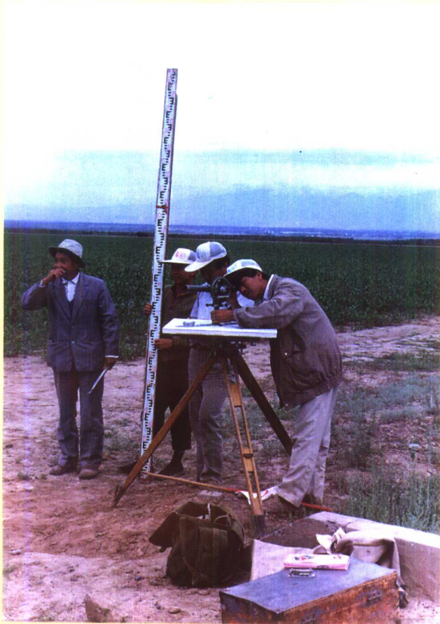
◀ 1990年,新疆测绘职工在乌鲁木齐经济开发区进行大平板仪地形测量。
