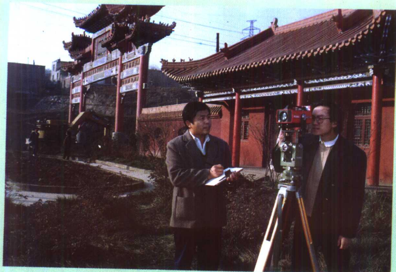
◀ 70 年代末,新疆各测绘单位开始陆续引进和采用电磁波测距仪。图为新疆测绘局职工在乌鲁木齐市,用测距仪进行测距观测。
