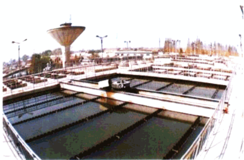
盐城市自来水厂净化池
