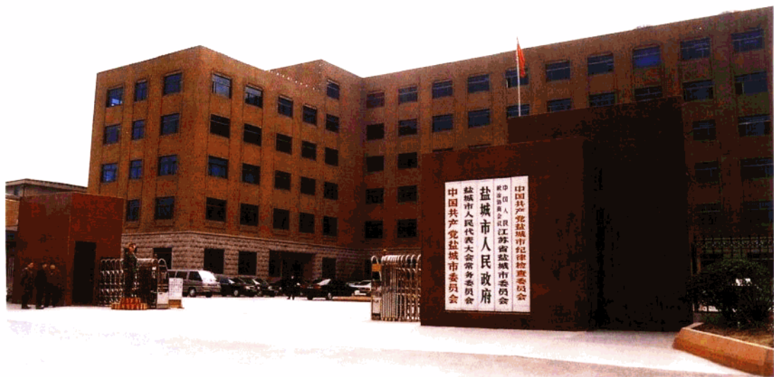
盐城市领导机关办公楼
