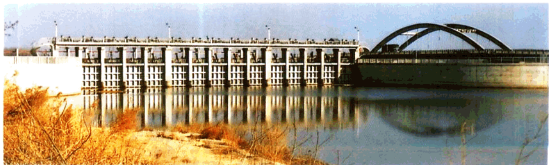
苏北灌溉总渠通榆河地涵工程
