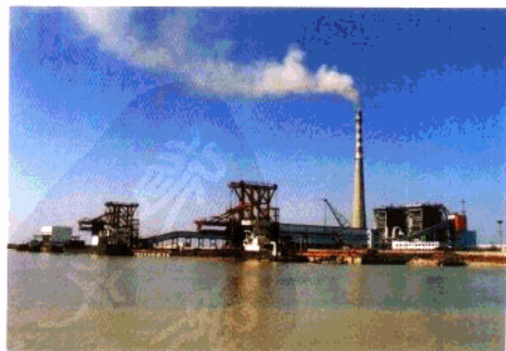
射阳港发电厂
