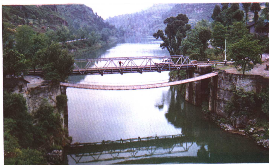
重安古铁索桥 田绍林 摄
