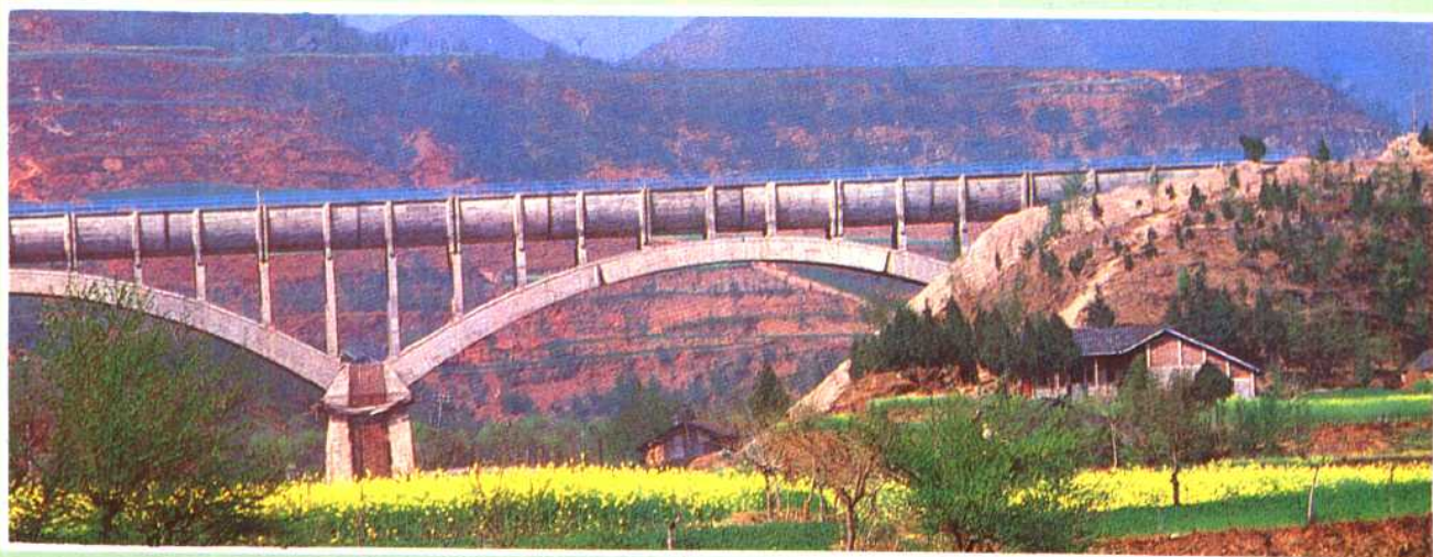
▲升钟水库渡槽
