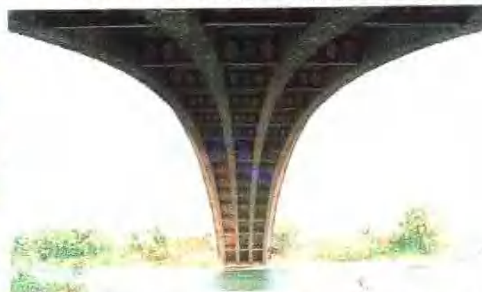
广西最大跨径的石肋双曲拱桥——灵山龙武大桥。
