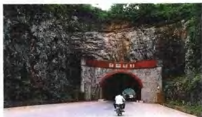
阳朔荆垭隧道。
