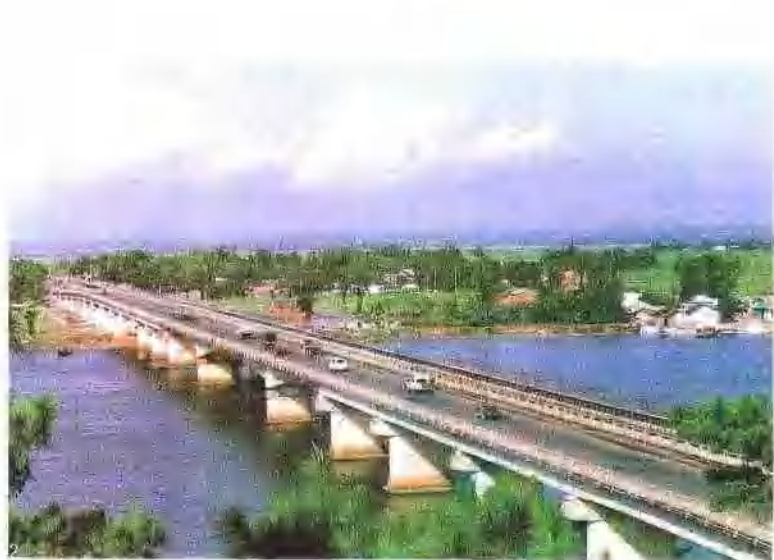
与铁路桥平行的茅岭江公路大桥。
