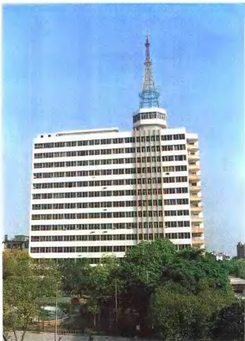
1988年建成的自治区交通厅办公大楼。
