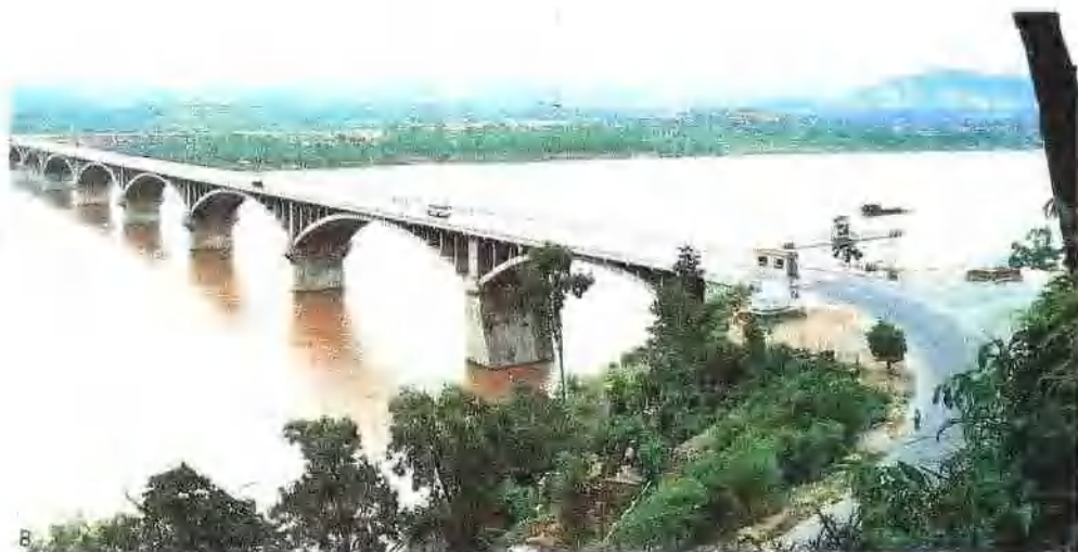
1990年建成的广西最长的梧州西江大桥。
