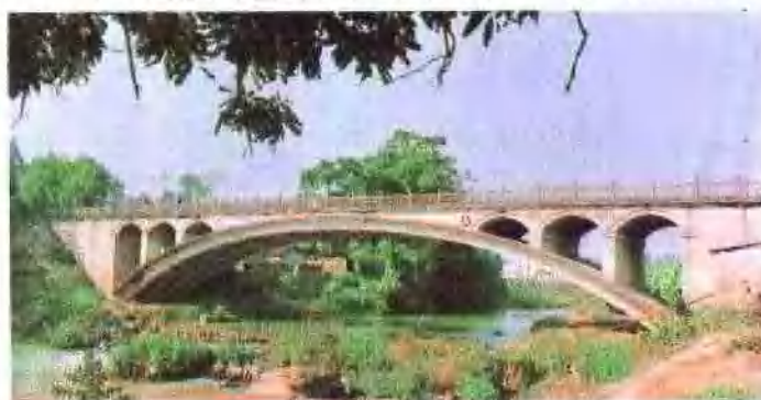
广西第一座无支架吊装的双曲拱桥——灵山三里江桥。
