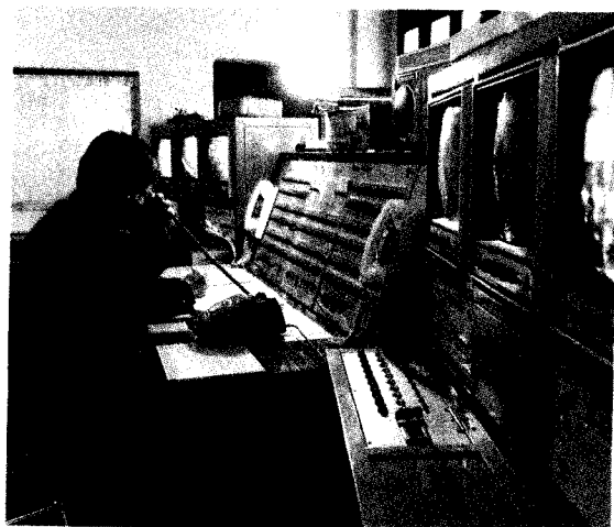
► 图为采用电话、电传和闭路电视监视、指挥生产的调度中心。
