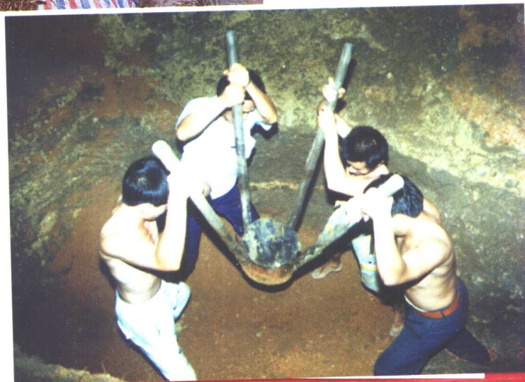
在高洪水位下及时清理和填筑 长江干堤上的蚁穴
