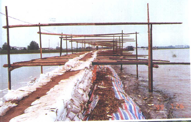
在两水夹堤 软基础上抢修的高架子堤
