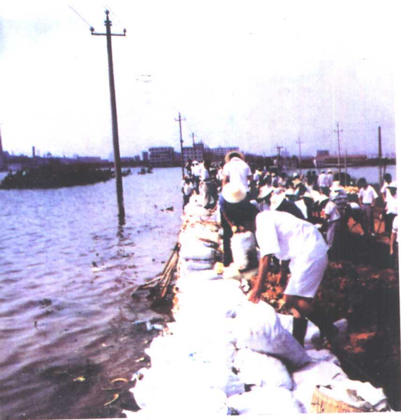
岳阳市直机关干部 在南津港大堤上抢筑子堤
