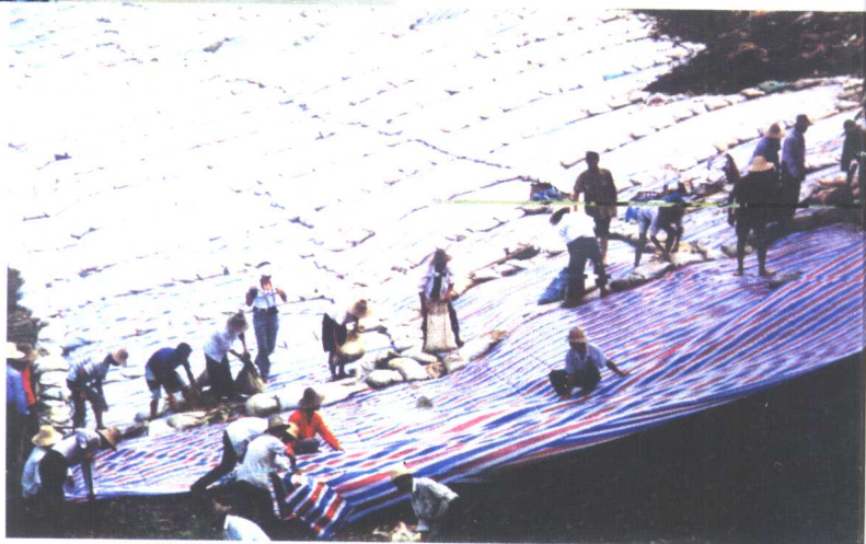
用彩条布铺盖大堤浸水面
