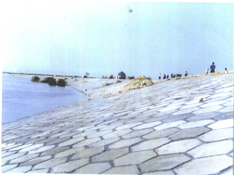
进行整治后的七弓岭岸坡
