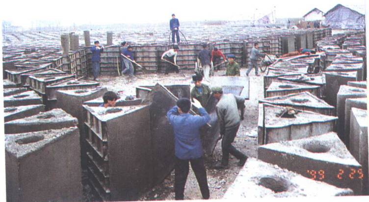
预制填充抗冲河段的水泥异形块
