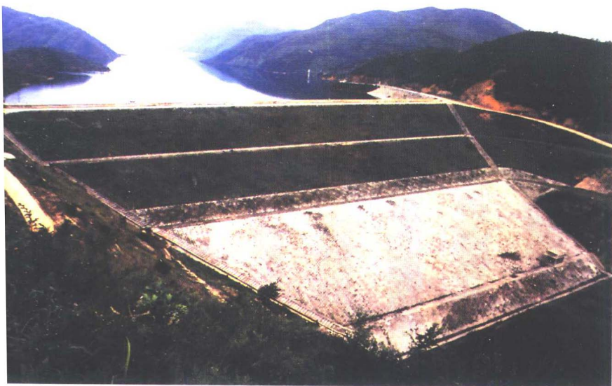
铁山水库大坝（斜墙沙壳坝）
