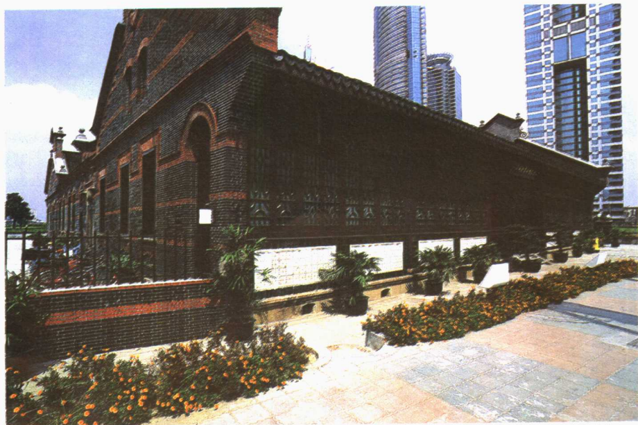
富有中西建筑特色的陈桂春住宅(现辟为陆家嘴开发陈列室)
