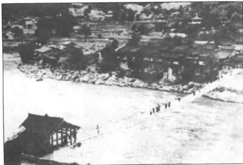
2. 大渡河上铁 索桥——泸定桥
