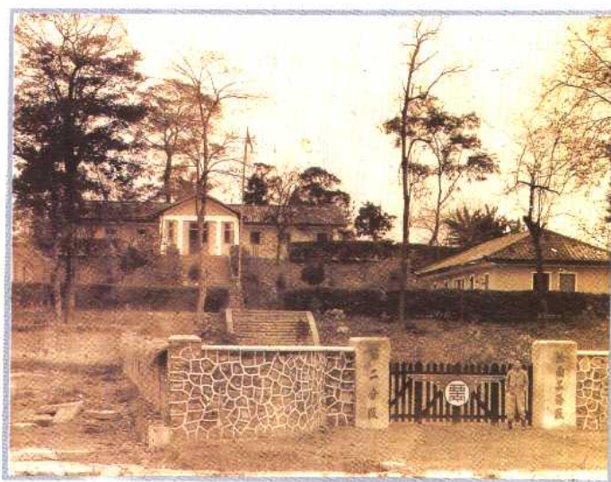
解放前的筑南工务段第二分段原址 (今独山公路养护段)
