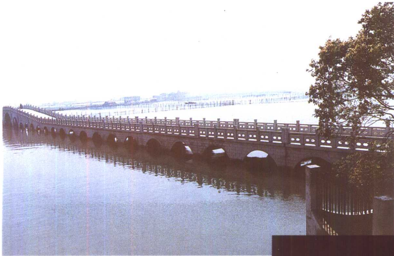
◀ 昆山市周庄南湖新建大桥
