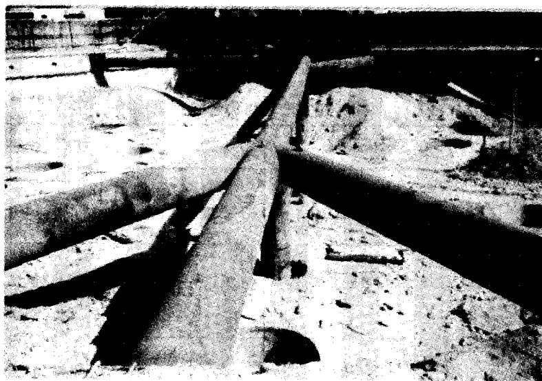
图 1-2 典型的传统方法:钢管撑
