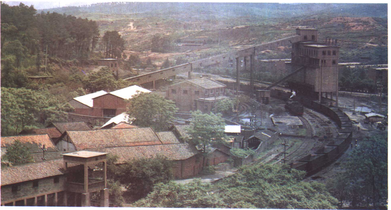
广西最大矿井——年产 60 万吨的东矿斜井
