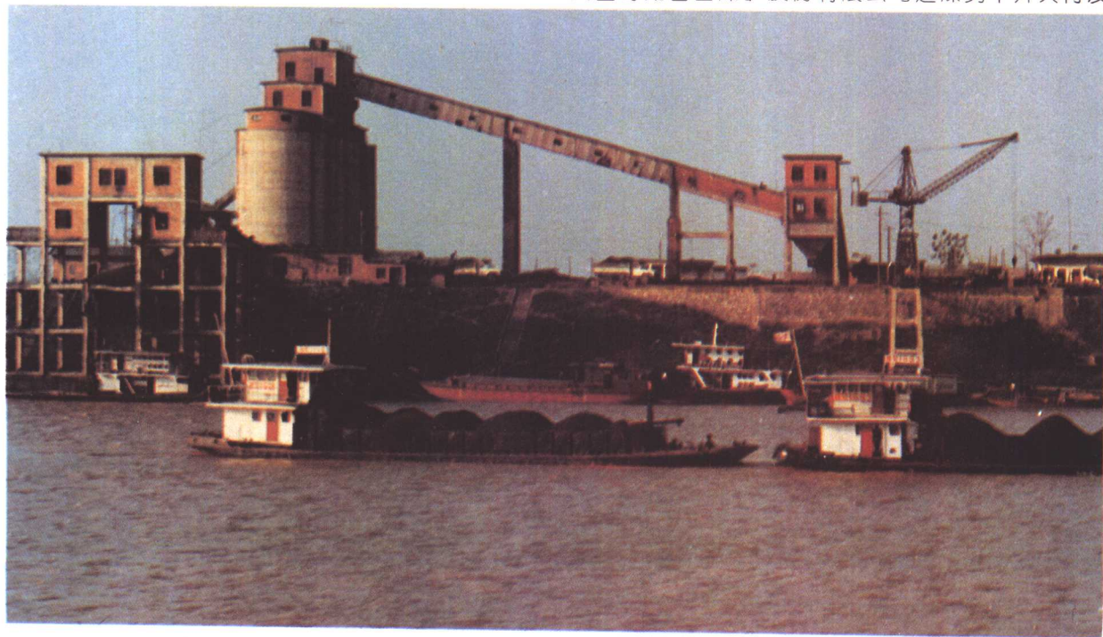
那龙煤矿煤仓码头
