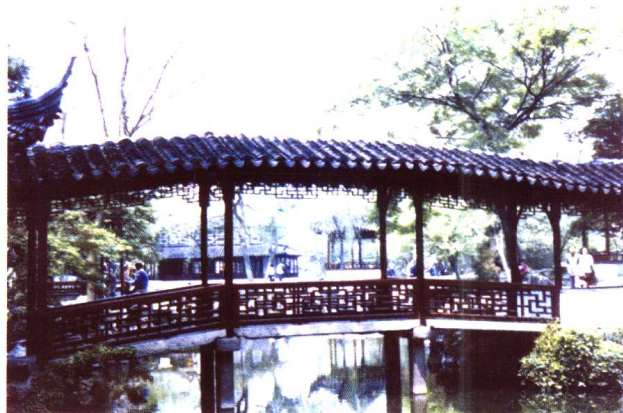
08 苏州拙政园廊桥
