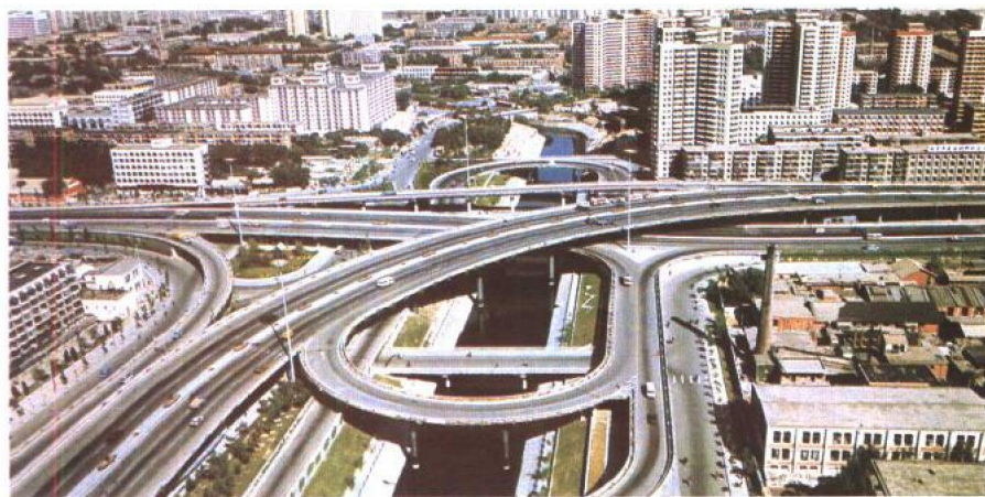
北京市政建设突飞猛进。图为新竣工的西厢工程 ——原载《北京日报》
