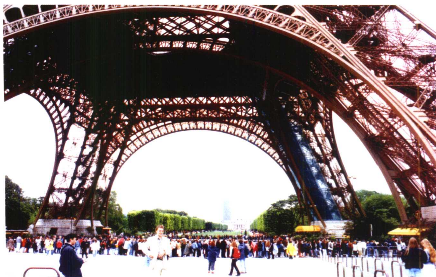
图7 艾菲尔铁塔巨型基座和排队登塔的人流
