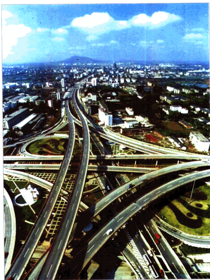
合肥五里墩立交桥
