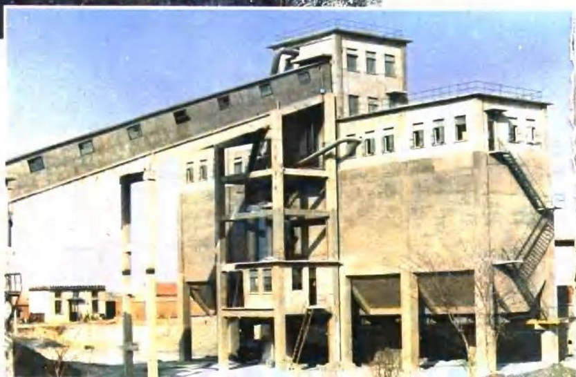
江苏省东海 蛇纹石矿破碎筛 分系统高架筛分 楼及矿仓
