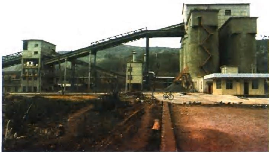
南京白云石矿转运站及通廊
