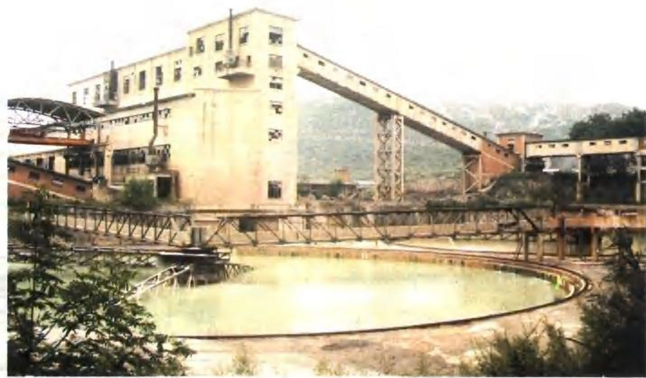
镇江船山石灰石矿洗矿车间的 \phi 53米尾矿浓缩池
