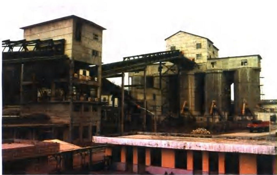
南京白云石矿 1 号转运站及圆筒矿仓（二次筛分）
