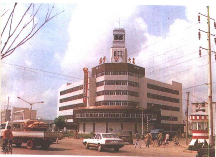
即墨物资贸易大楼
