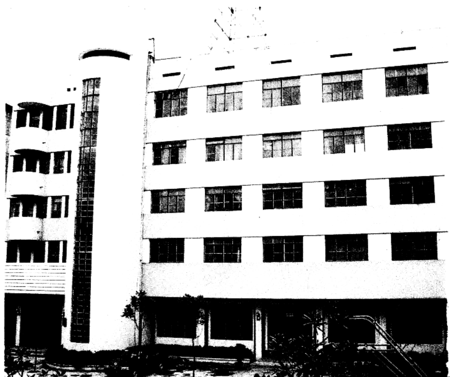
温州市工商行政管理干部学校教学楼
