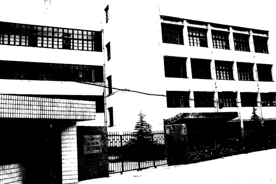
温州市工商行政管理局办公楼
