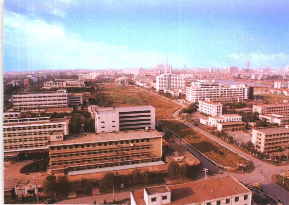
天津市新技术产业园区
