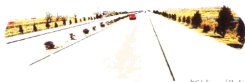
新墟一级公路
