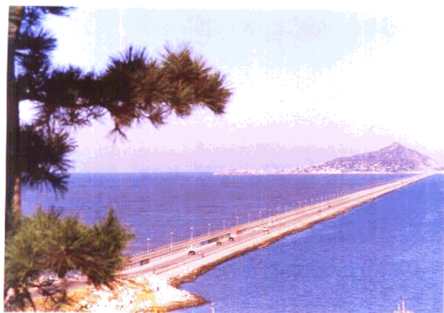
神州第一堤——连云港西大堤
