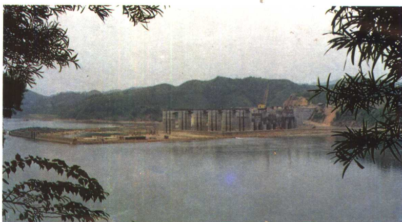
▲ 在建装机 5.4 万千瓦融江浮石水电站
