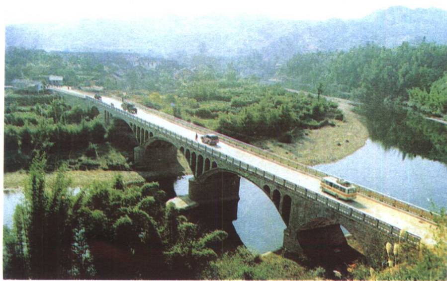
▲ 岗伟村公路桥
