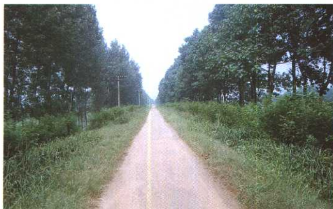
河道“五化”堤防
