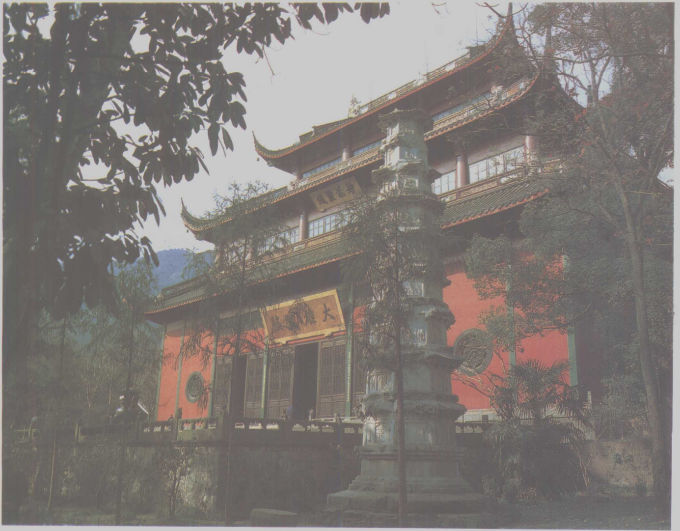
△座落杭州西湖西北靈隱山麓的靈隱寺
