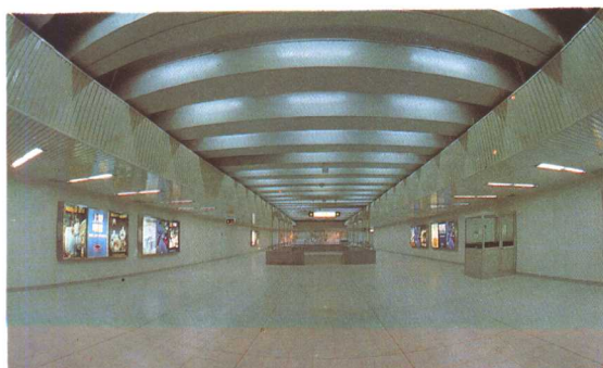
地铁一号线南端锦江乐园至徐家汇段已建成通车
