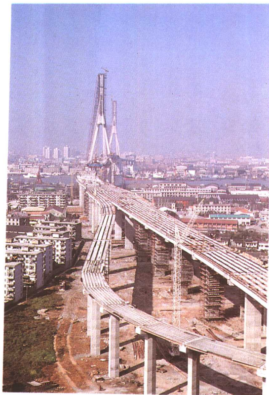
建设中的杨浦大桥 (建成后, 跨度居世界同类型大桥第一位)
