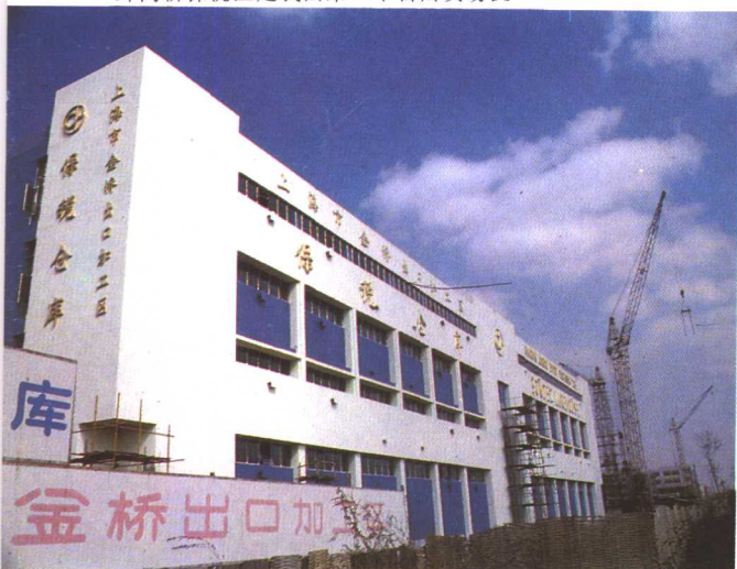
建设中的金桥出口加工区
