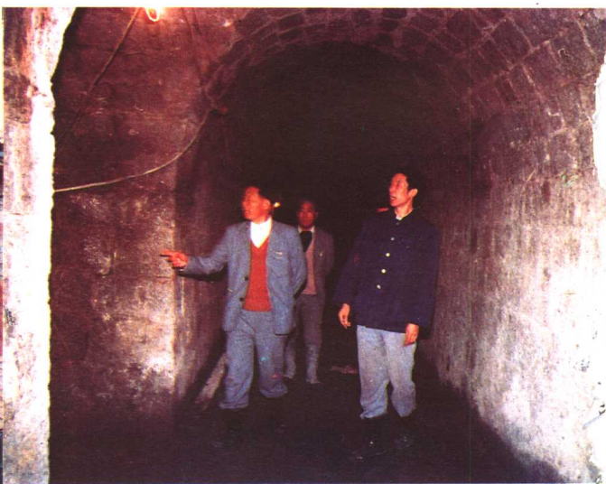
检查维护防空工事
