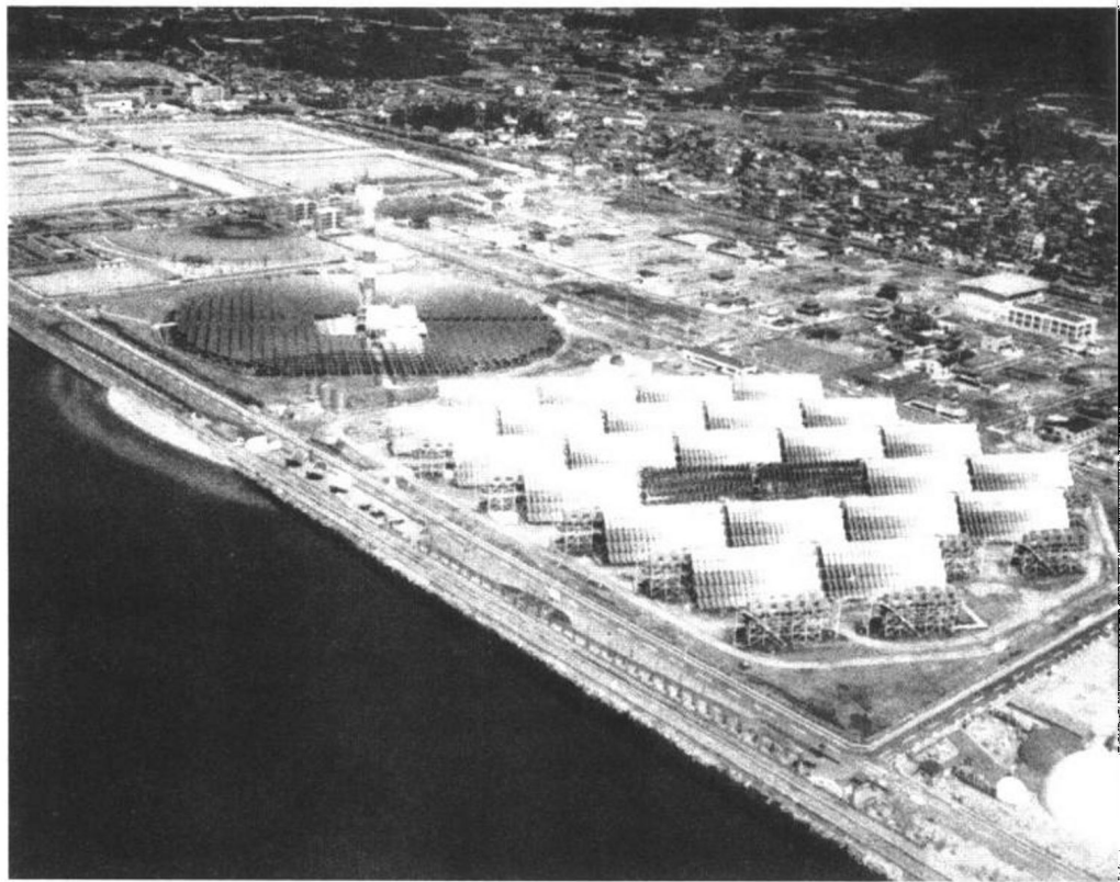
▲1989年,日本学者提出建立全球太阳能电池能源网的设想。图为一座太阳能热发电厂的采光板群。左为塔式采光方式,右为曲面采光方式。
