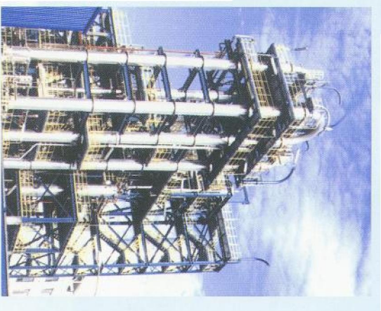
荆门石化总厂PP总承包项目
