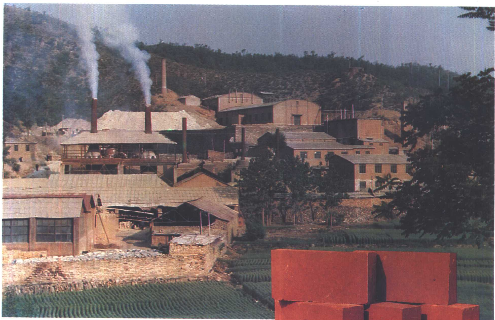
邢台菱镁矿生产车间
