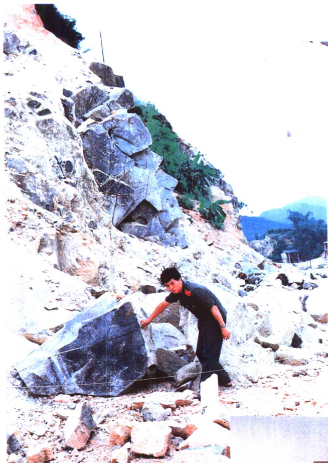
检察人员在勘查事故现场
