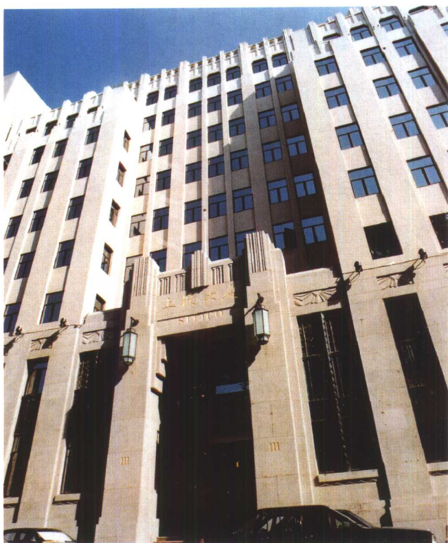
上海国际信托投资公司九江路办公大楼
