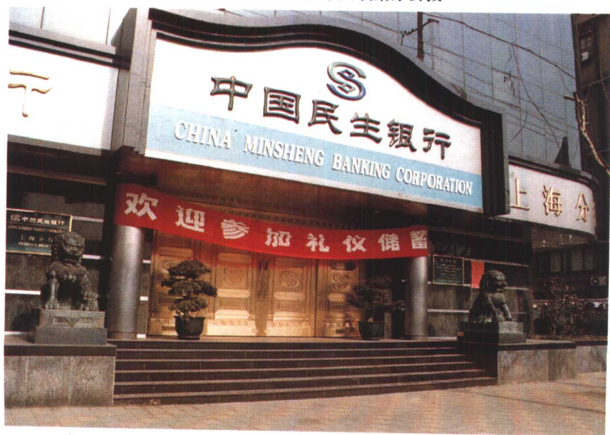
民生银行上海分行东大名路办公楼
