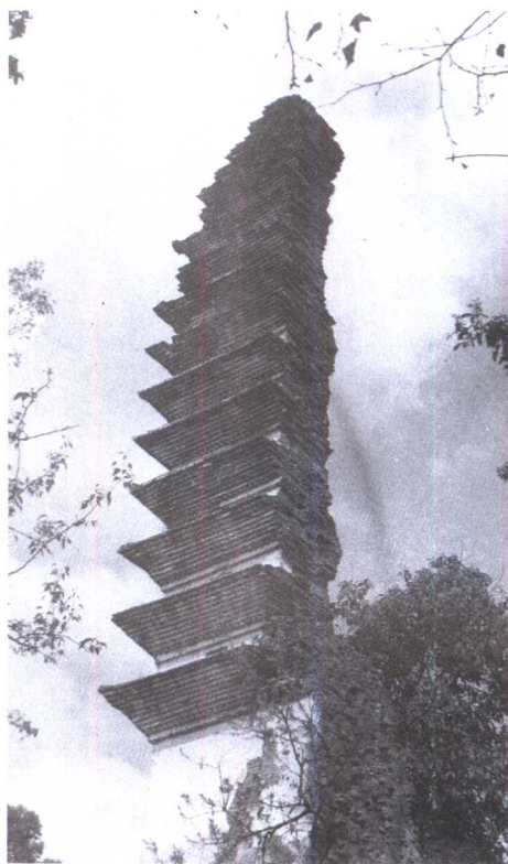
彭县龙兴寺残塔(解放初期)
