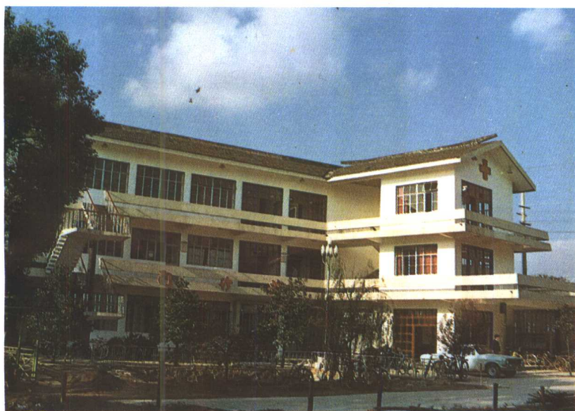
梅李中心卫生院门诊部
