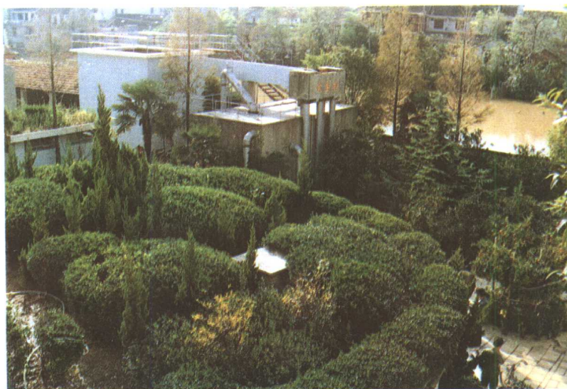
自来水厂蓄水池
