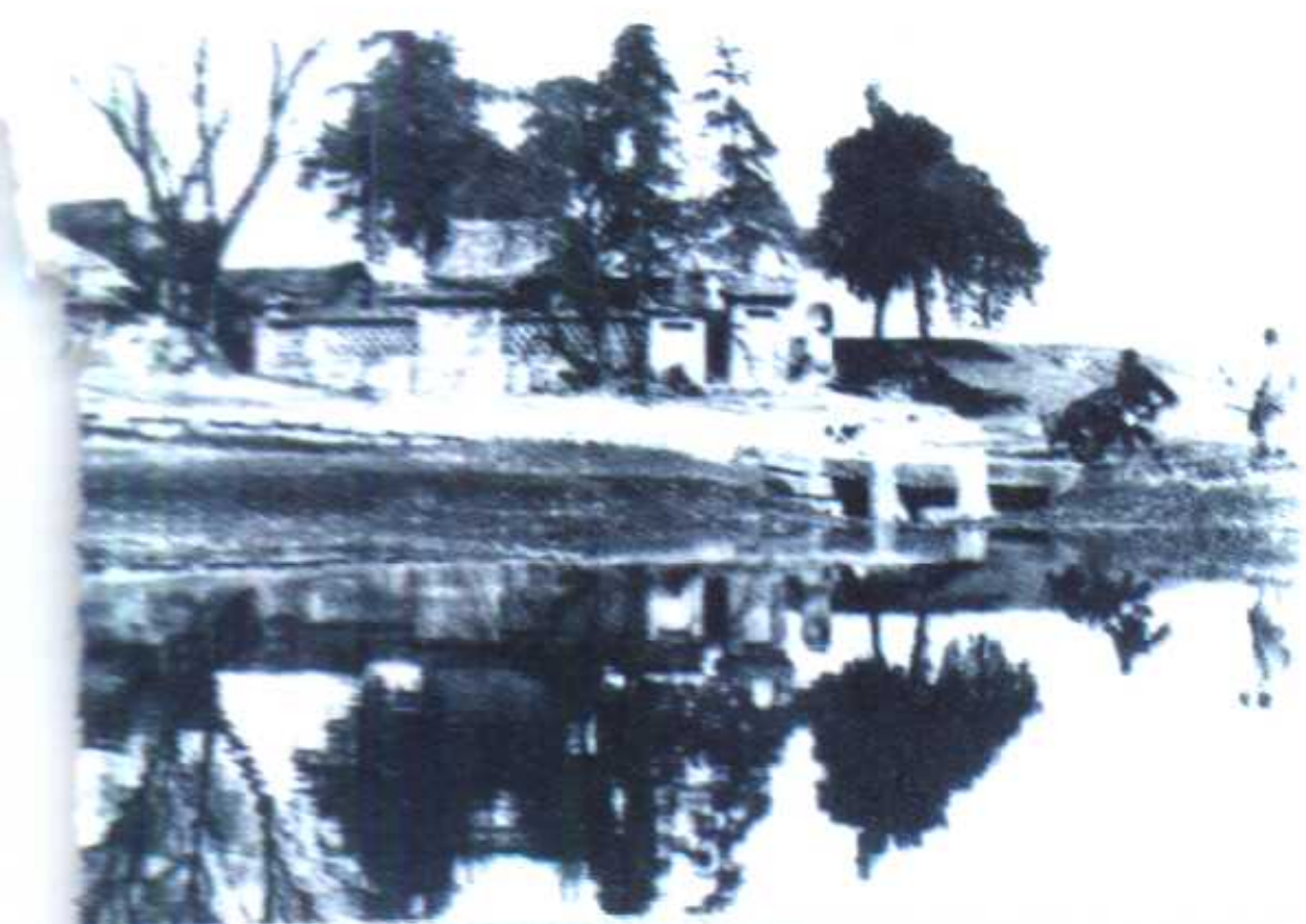
民国时期高家园滚水桥
