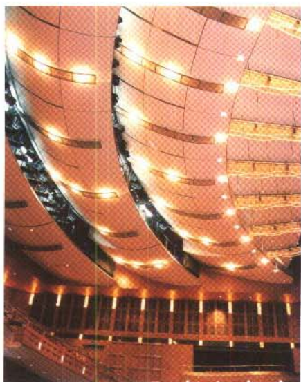
剧场吊顶局部
