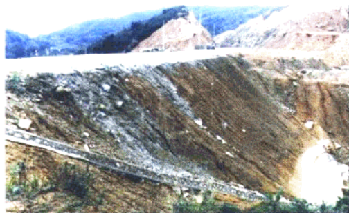
彩图2 由工程建设引起的面蚀和沟蚀
