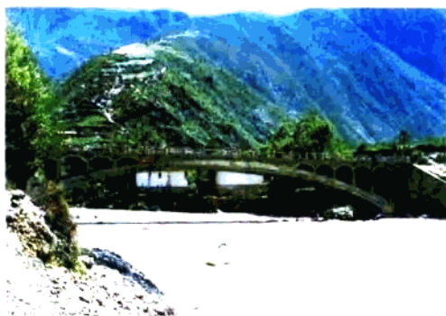
以工代赈建设的立节白龙江大桥
