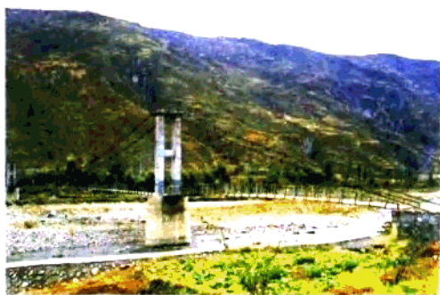
以工代赈建设的文县杨家坝吊桥
