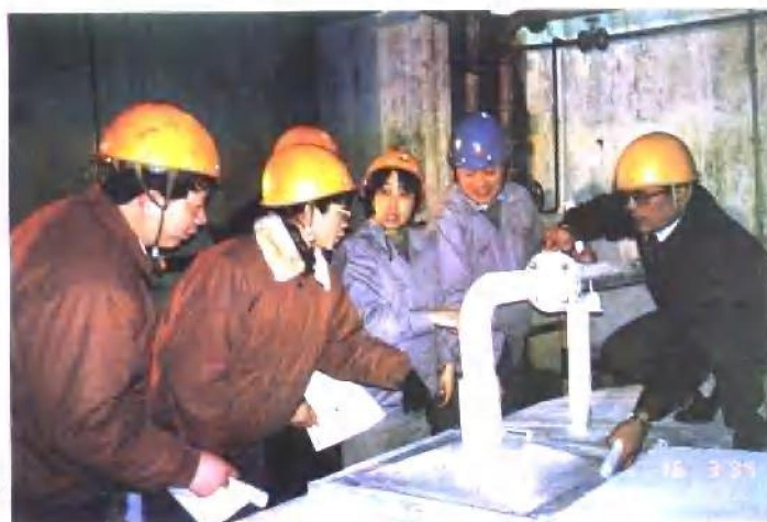
▶ 宝钢（集团）公司评审员正在冷轧厂能源介质车间进行现场检查。
