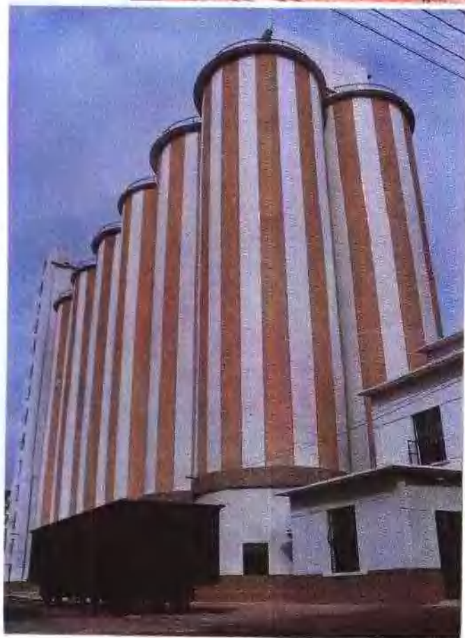
南宁市白苍岭大米厂粮食仓库。
