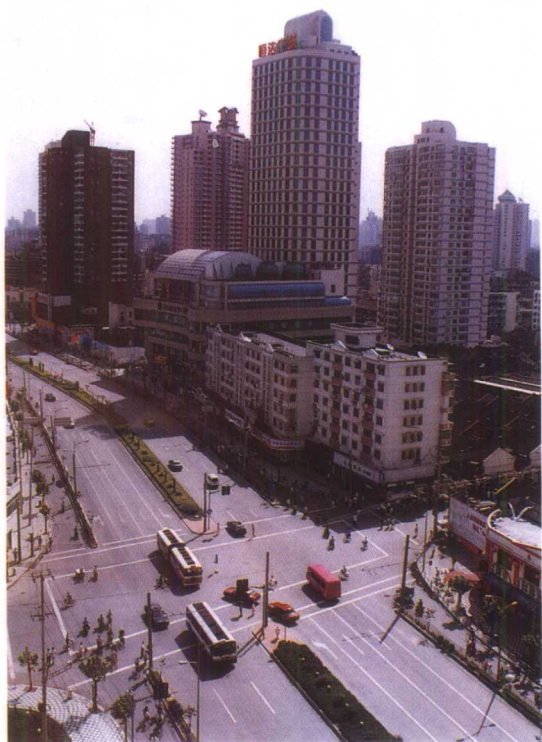
拓宽后的长寿路新貌
